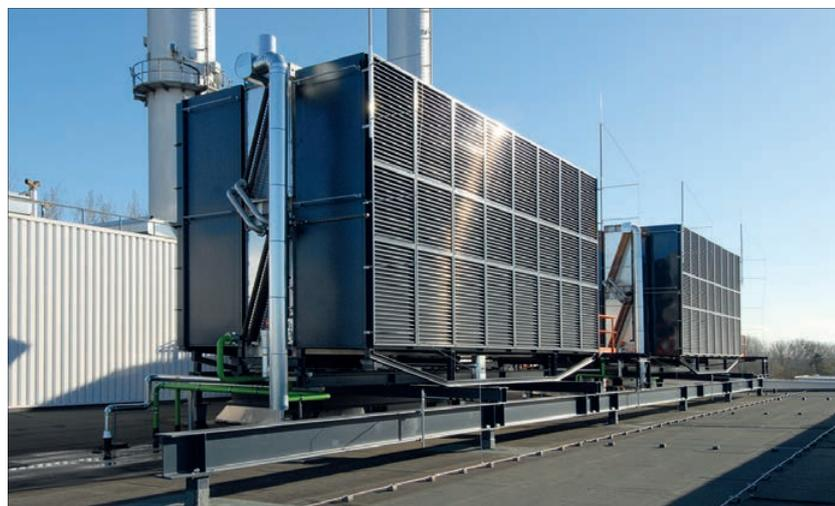
Bild 5. Filterhäuser mit hybrider Verbrennungsluftkonditionierung und dreistufiger Luftfilterung
